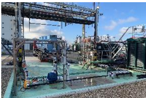
✓ Déplacement du poste de déchargement d'acide chlorhydrique
