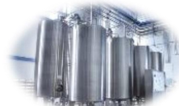
Remplacement Cuves (Labo inclus système de gestion, Tuyauteries, Hydrolyseur)
